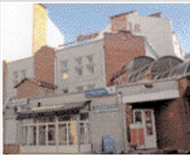
102-квартирний житловий будинок із вбудованим торговельним центром
